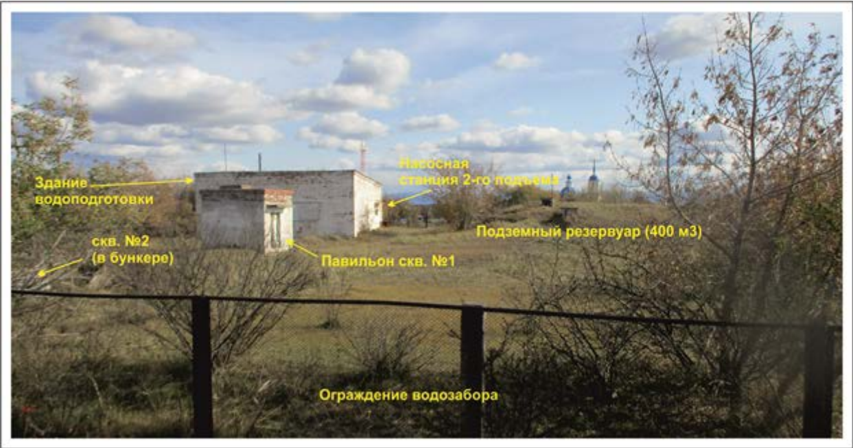
Рис. 1. Общий вид на водозабор
